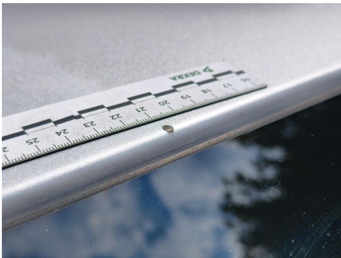
Fot. 68 Dach - zdjęcie poglądowe 1
